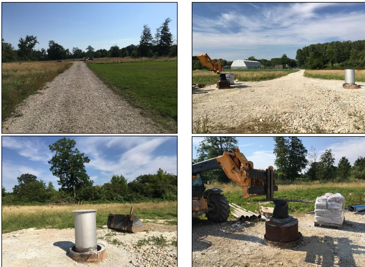
Figure 3 : Reportage photographique de l'environnement immédiat des captages
